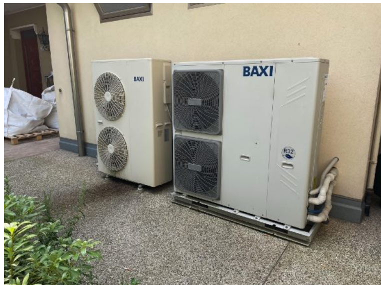
Impianto esterno (pompe di calore) comune (piano terra)
