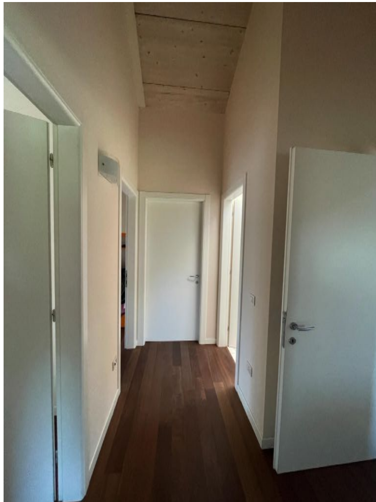
Disimpegno (secondo piano)
