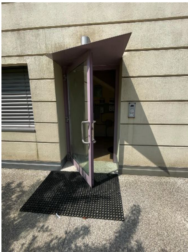
Ingresso comune (piano terra)
