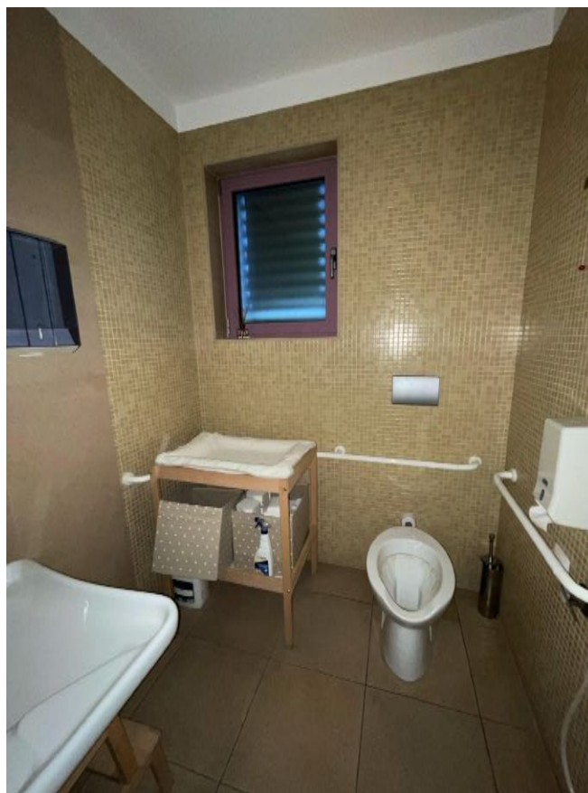
Bagno (piano terra)
