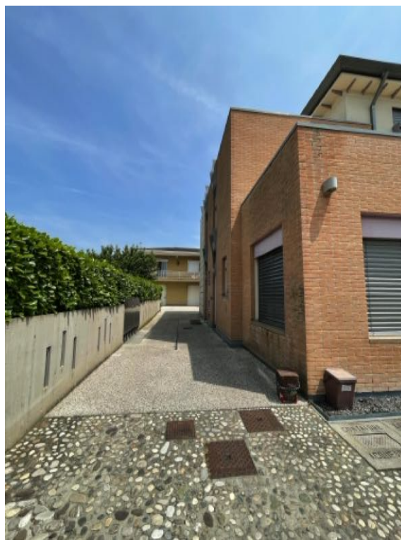
Scorcio prospetto Nord dell'edificio - area scoperta comune
