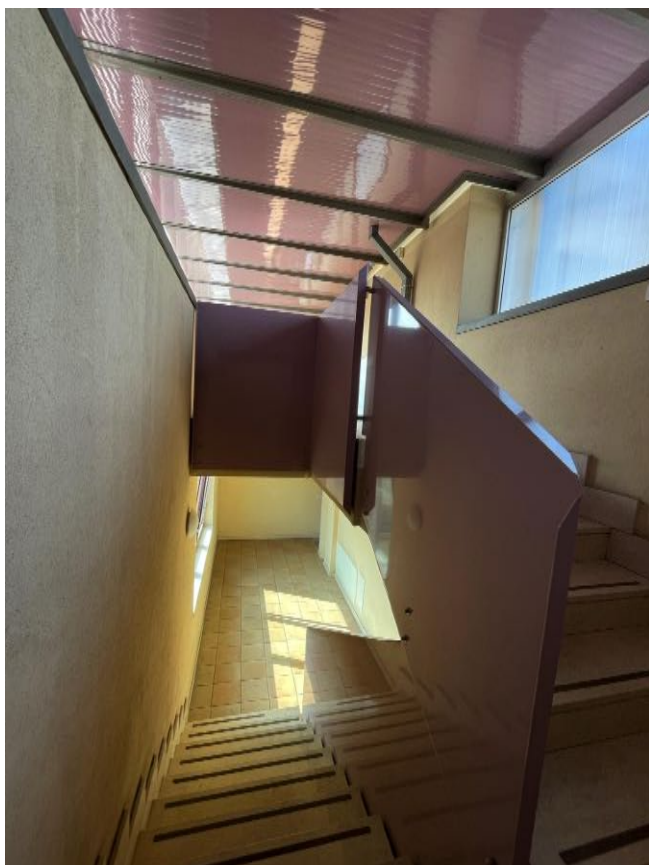
Vano scale comune
